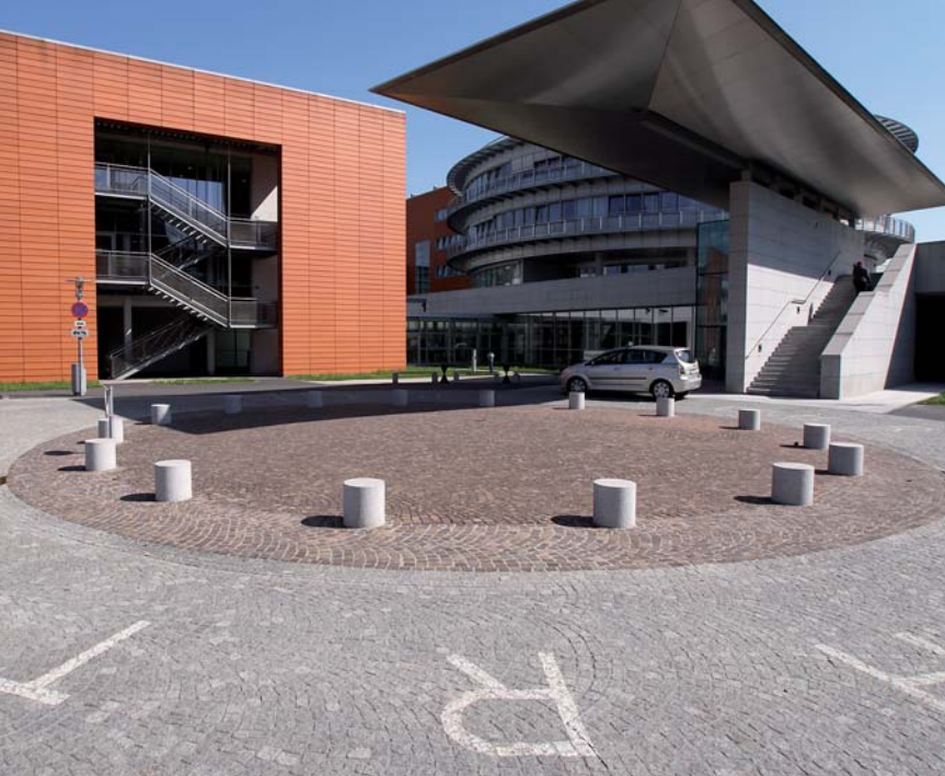
Eingangsbereich der Landes-Nervenklinik Wagner-Jauregg vom Architekten Wilhelm Holzbauer: Fassaden, Innenböden und Außenanlagen sind mit Graniten aus dem Mühlviertel gestaltet.
